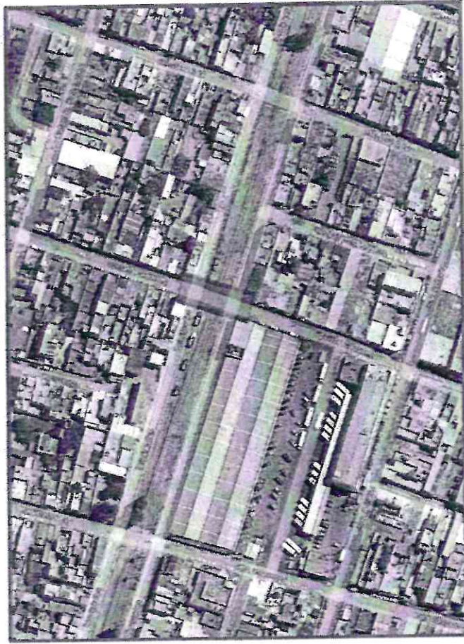
Hincado cruce tubería de drenaje FFCC Sánchez Torrado
