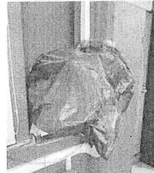
Derivado de la falta de impermeabilización se observan algunas manchas por donde escurre al agua de lluvia, dando a la necesidad de "tapar" con algunas bolsas los equipos electrónicos y así evitar que se mojen.
