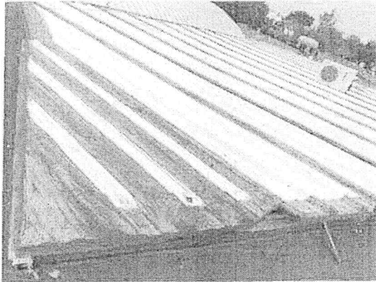
Techo parcialmente impermeabilizado, tapando únicamente los lugares donde se presentan goteras sobre el Área de Construcción del Organismo.
