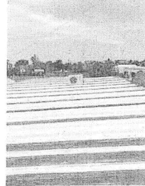
Techo parcialmente impermeabilizado, tapando únicamente los lugares donde se presentan goteras sobre el Área de Construcción del Organismo.
