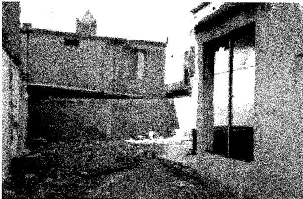
Privada Fresno con levantamiento de hasta el 40. Cm.
