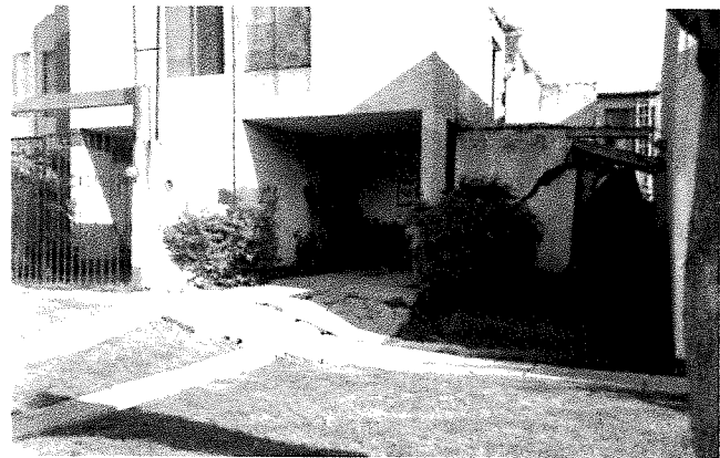
Privada Fresno con levantamiento de hasta el 40. Cm.
